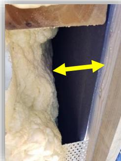
Lame d'air entre la mousse et le film pare vapeur favorisant les propagations verticales
