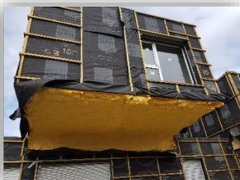
Sous face des déports de containers ou de carport tapissée de mousse
